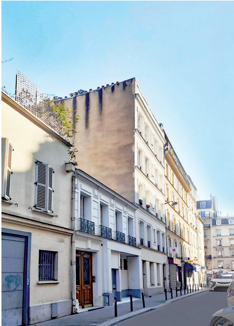
AVANT - L'EXISTANT AU 8 RUE DES APENNINS
