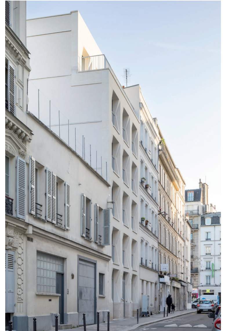
APRÈS - LE PROJET AU 8 RUE DES APENNINS
