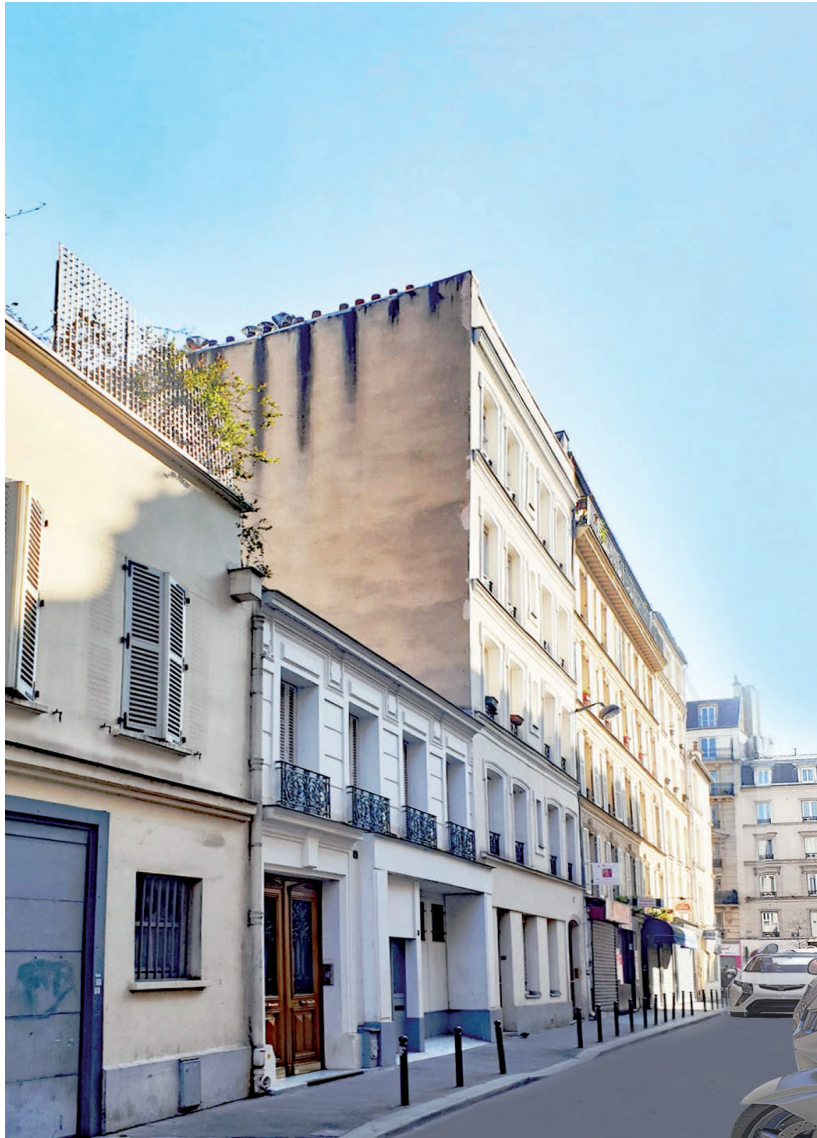
AVANT - L'EXISTANT AU 8 RUE DES APENNINS
