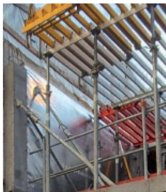
Façade en ossature bois (FOB) entièrement préfabriquée hors site
